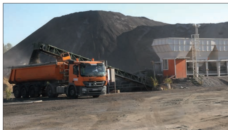
Die Mineralgemische werden in dieser Anlage genau dosiert und auf die Lkw verladen.
